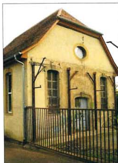
ehemalige Synagoge Heinsheim nach der Dachsanierung Foto: Bernd Göller
